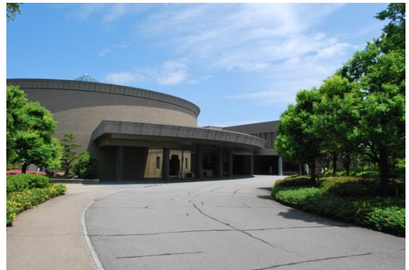
金沢市南斎場外観
